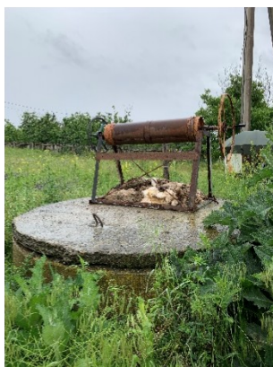
Fig. 5 Foto - Zona de captare Sonda Nr. 90
