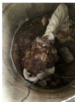
Fig. 6 Foto - Zona de captare Sonda Nr. 1288
